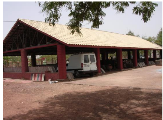
Photo A 2.6 : Hangar de cure sèche
