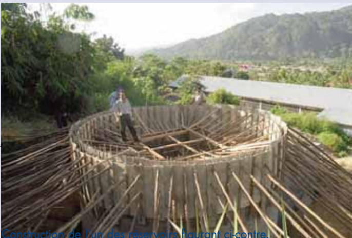
Construction de l'un des réservoirs figurant ci-contre.
