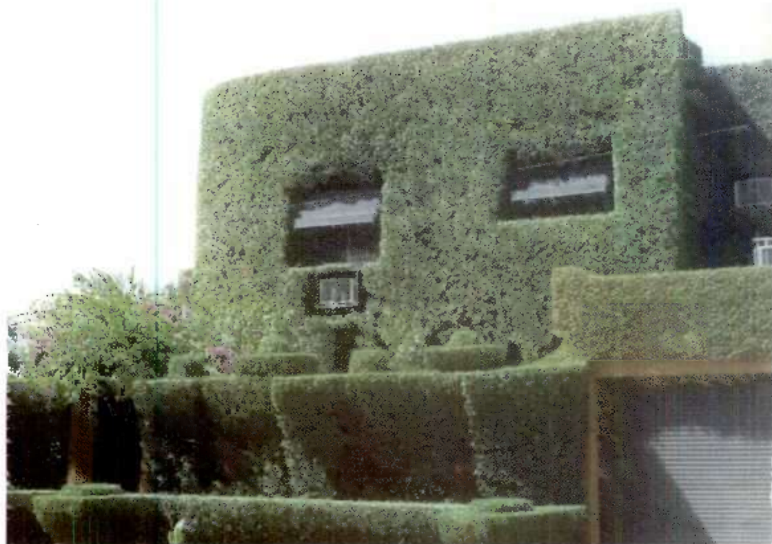
Figure 7 b: Protection de façade est par rebords de fenêtre et végétation
