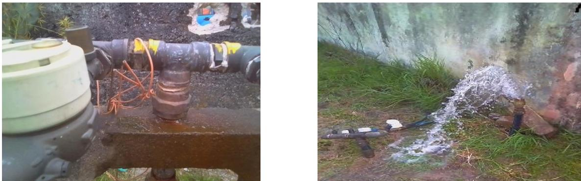
Figure 16. **Oxydation des raccords en laiton qui relient les nourrices au branchement (MOUKET, 2017)**
