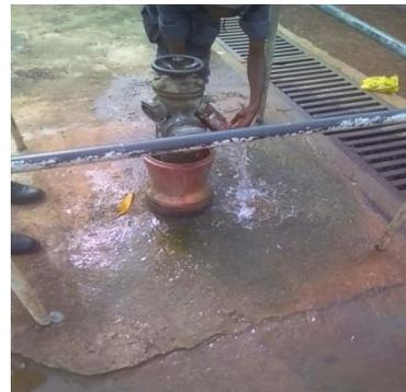
Figure 23. **Pertes en eau dues à une fuite sur la conduite qui alimente une bouche d'incendie privée du camp de gendarmerie d'Owendo et gaspillage sur le campus de l'USS et à l'école publique de Dragages (MOUKET, 2017)**
