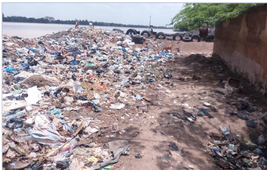
Figure 12 : Dépotoirs d'ordures aux abords du barrage n° 2 (Dapoya, septembre 2018)
