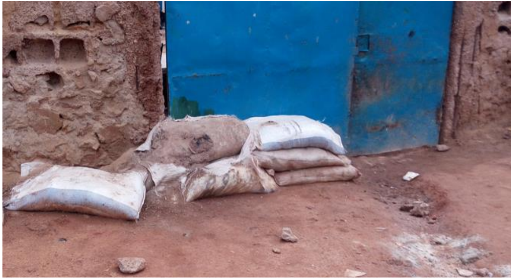
Figure 23: Sacs pour l'endiguement aux alentours des portes (Dapoya, septembre 2018)
