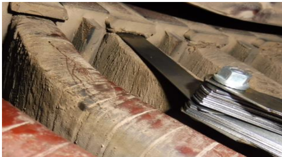
Figure 14: Schéma illustratif du calage défaillant
