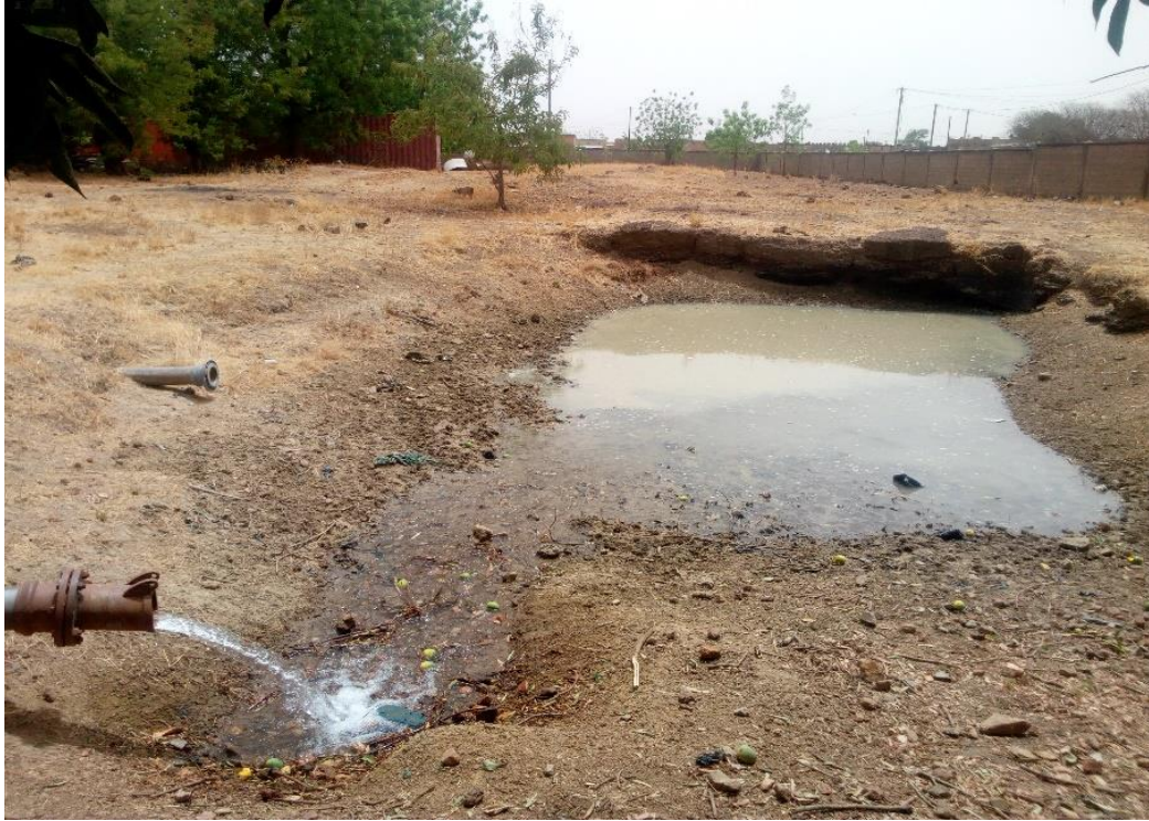
Figure 9: Débordement au niveau de la bache Station I
