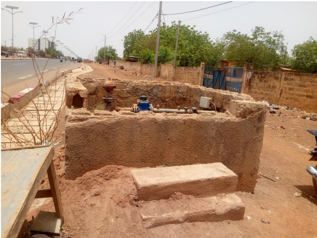
Figure 11 : Tête du forage F15 non protégé
