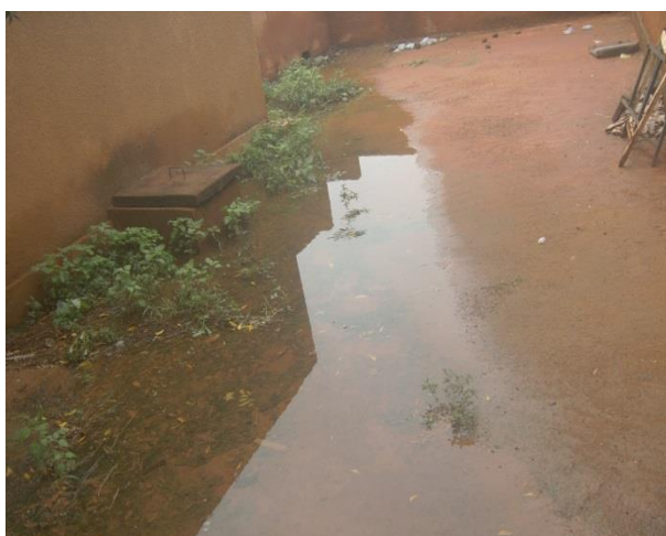
Stagnation d'eau causée par une construction d'infrastructure
