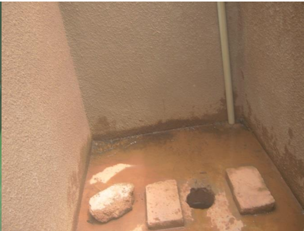
Latrine du CDT utilisée à la fois comme douche et latrine
