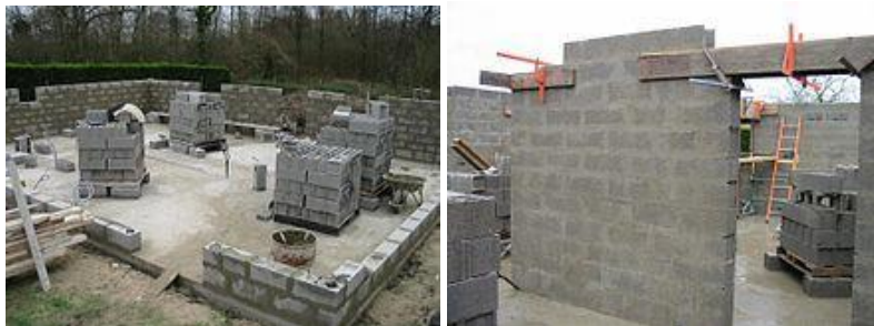
Figure 1 : Constructions en agglomérés de béton
