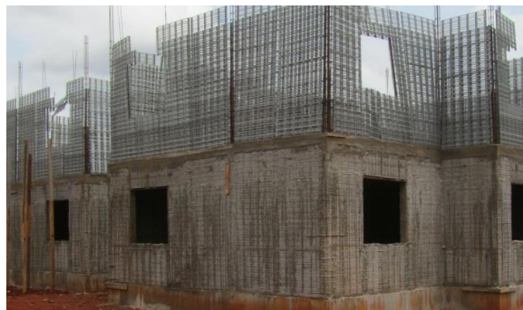
Figure 2 : Constructions en mur de COFFOR à Olembé
