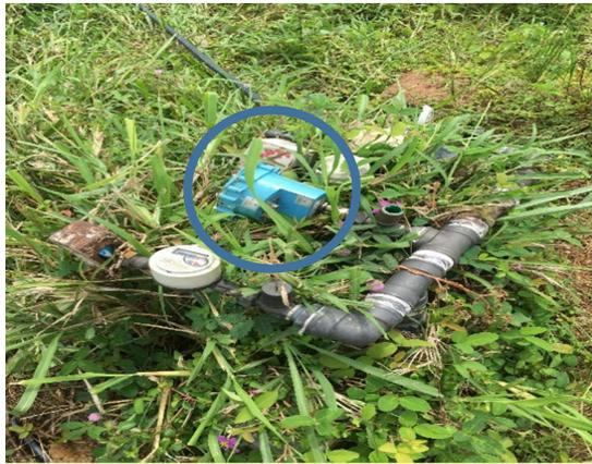
Figure 4 : Mesure de pression à l'aide de OCTOPUS LX
