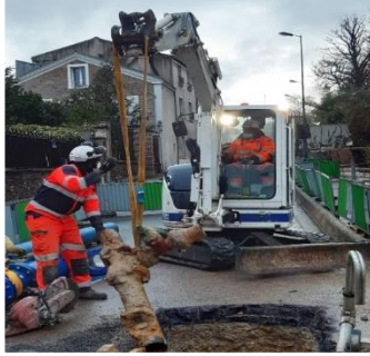
Figure II-6: Chantier de Garches.
