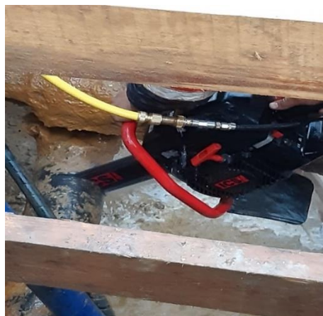
Figure II-4: Découpe de tuyau.
