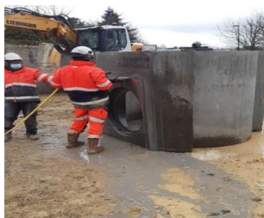
Figure II-9 : Découpe d'une chambre de vanne
