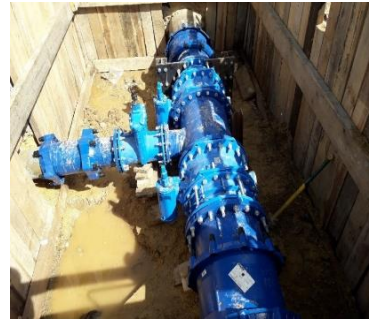
Figure II-7: Chantier de Garches, remplacement de vanne d'eaux.
