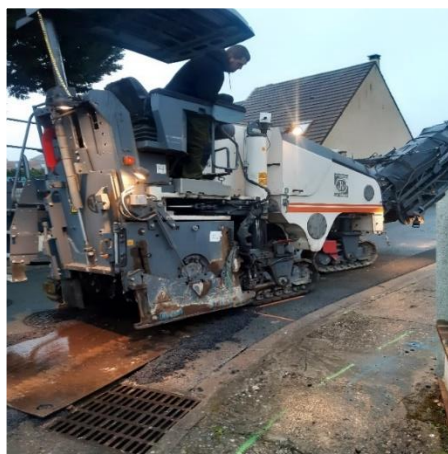
Figure II-11 : Rabotage
