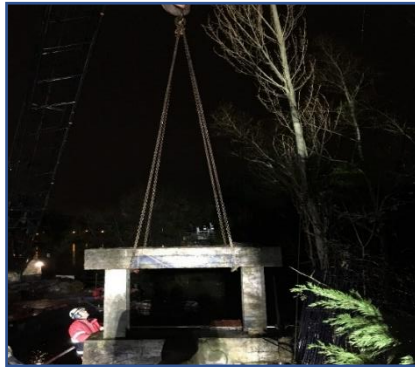
Figure II-5: Découpe des appuis d'un pont.
