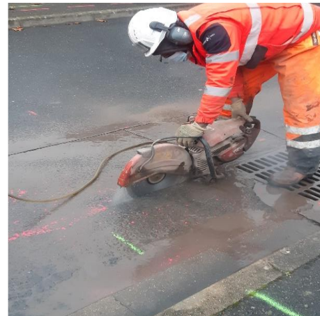
Figure II-8 : Découpe pour sondage
