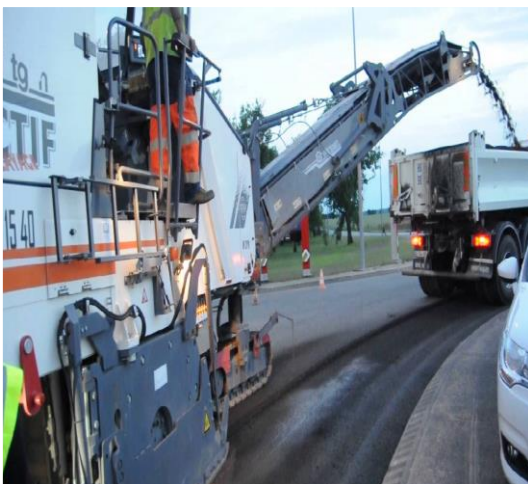
Figure II-1: Rabotage de la chaussée
