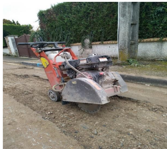
Figure II-2: Découpe des enrobés
