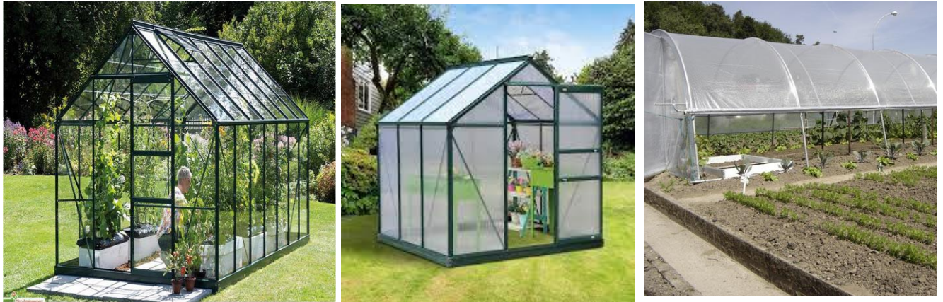
Figure 8 : Quelques exemples de matériaux de couverture d'une serre : (a) serre en verre ; (b) serre en polycarbonate ; (c) : serre en polyéthylène
