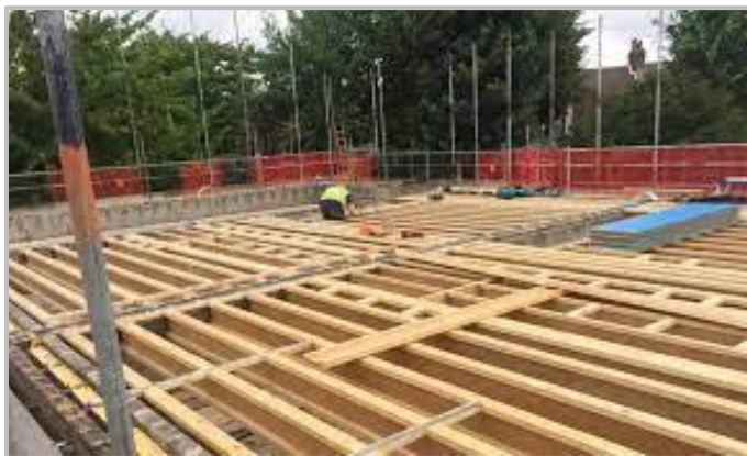
Figure 38 – Illustration de réalisation d'un plancher en Profilé FJI 350
