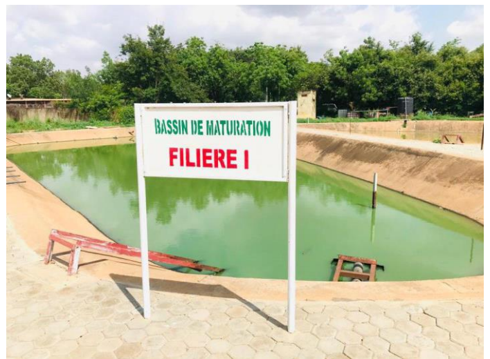
Figure 8 : Bassin de maturation de la filière I
