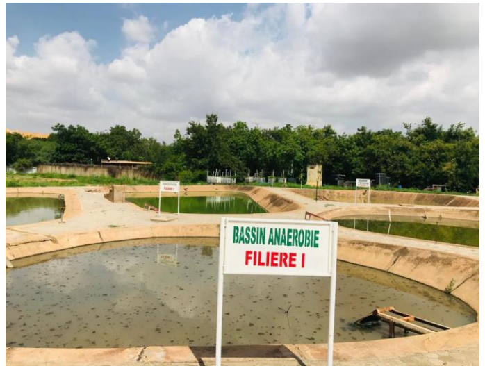
Figure 6 : Bassin anaérobie de la filière I
