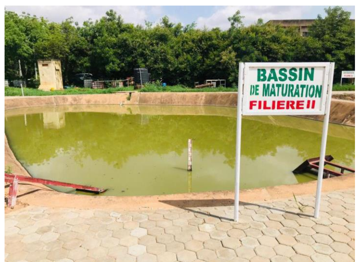
Figure 10 : Bassin de maturation de la filière II
