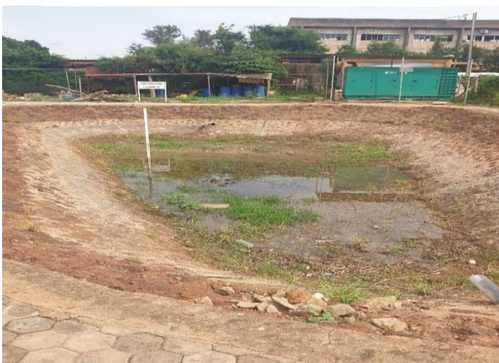
Figure 9 : Bassin de maturation de la filière III
