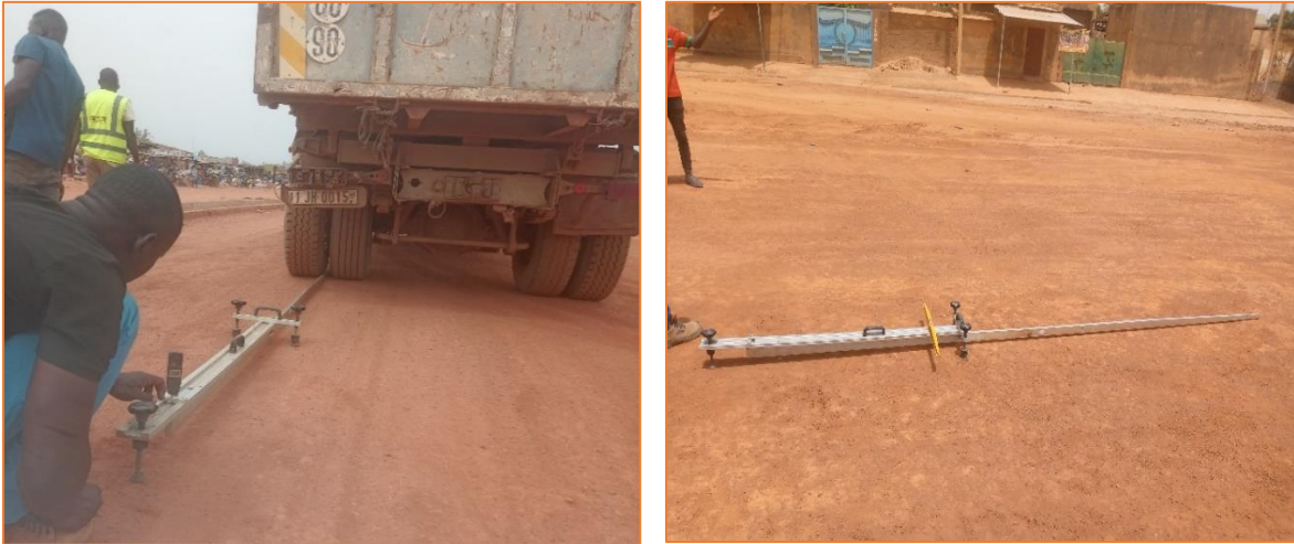
Figure 28: Mesure de déflexions sur la couche de fondation
