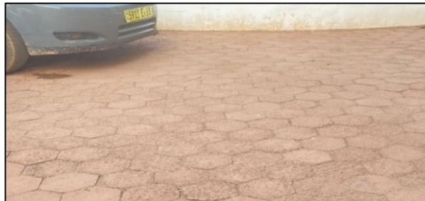
Figure 16 - La présence de rugosité exagérée ou de crevasses
