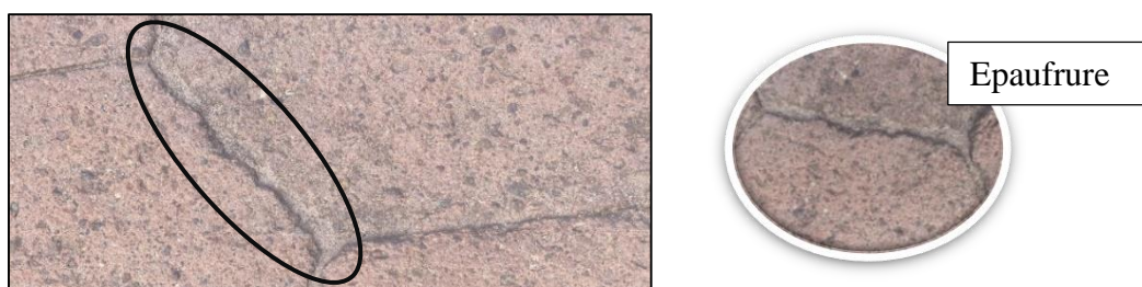
Figure 13 - Présence d'épaufrures
