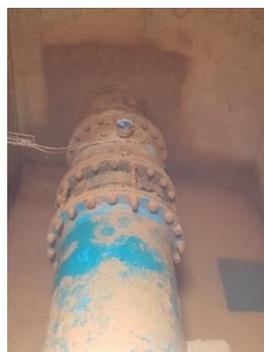
Figure 37 : Vue intérieure du regard de capteur de débit électromagnétique
