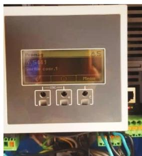
Figure 35: Promag 50W : Erreur de dispositif S...#012
