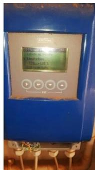
Figure 40: Réglage de l'échelle de mesure sur IFC100W
