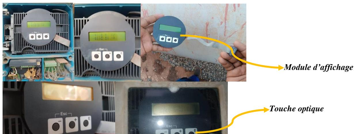
Figure 36 : Symptômes de modules d'affichage défectueux : Promag 50W
