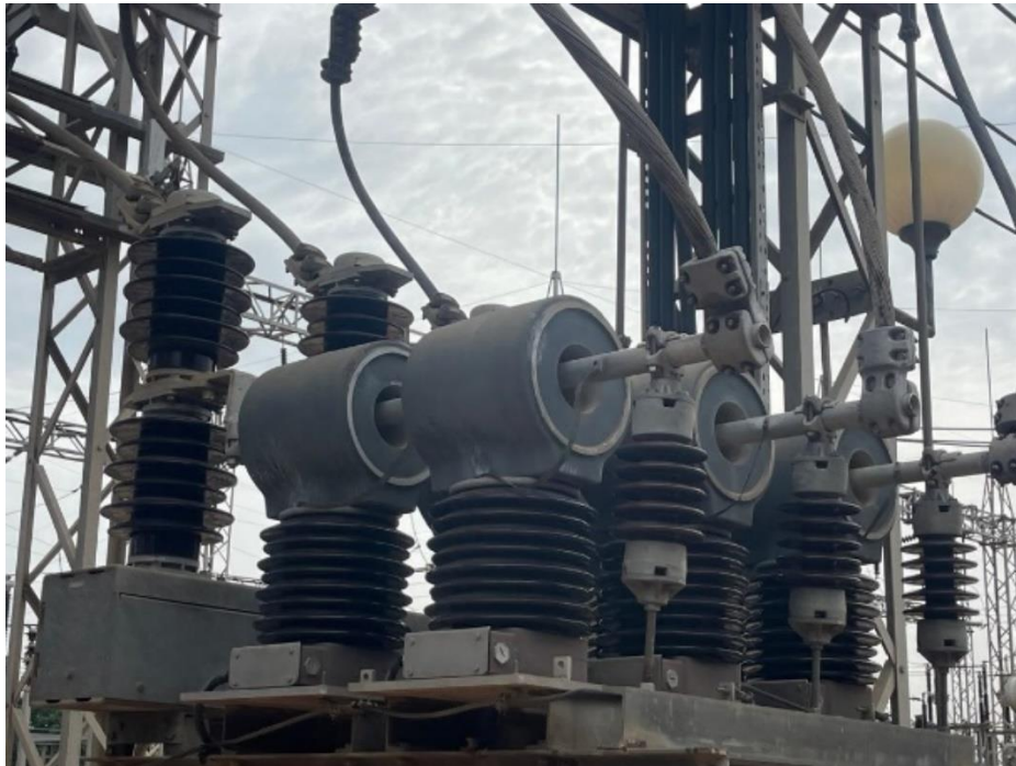
Figure 15 Transformateur de Courant
