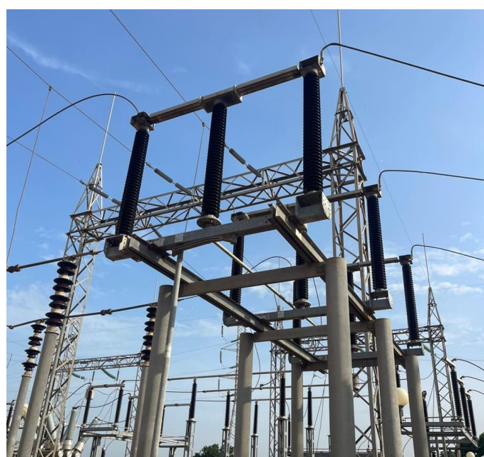
Figure 10 : Sectionneurs du champ électrique
