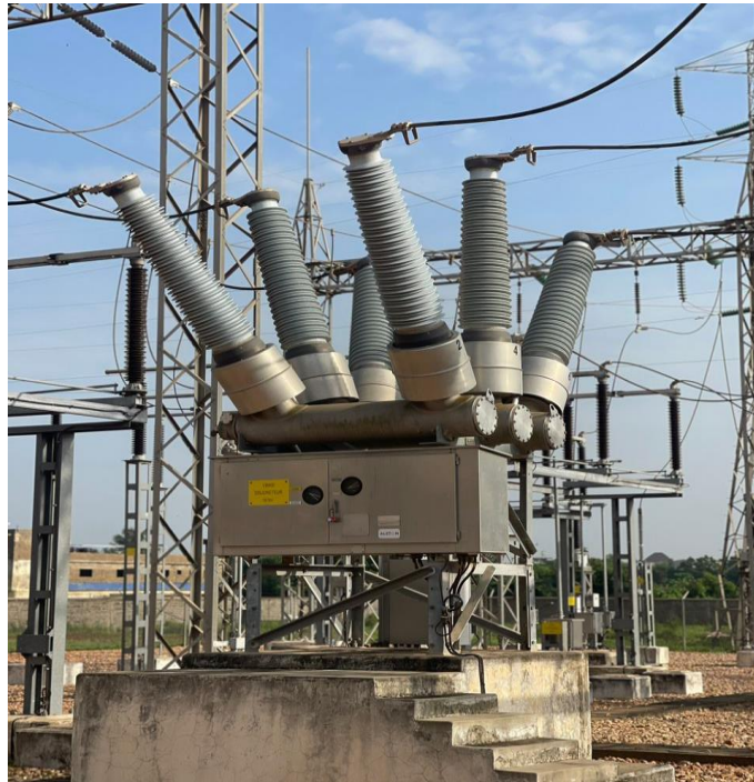
Figure 7 : Disjoncteur Deak Tank
