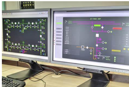
Figure 16 :Interface Système SCADA dans un poste électrique(13)
