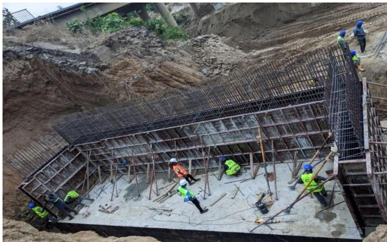
**Figure 7 : Exécution du coffrage**
