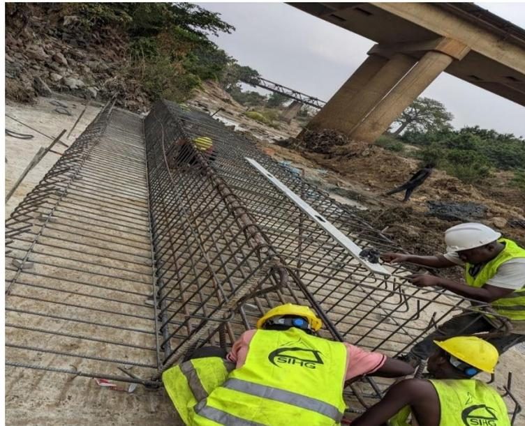
**Figure 6** : Exécution du ferrailage
