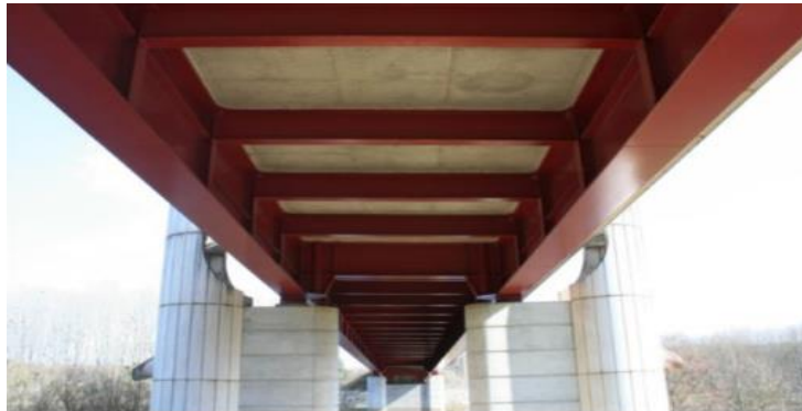
Figure I-5 :Pont à poutres mixtes Acier-Béton[19]
