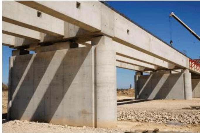
Figure I-3 : Pont à poutre en Béton armé –Ligne TGV _entre Nîmes et Montpellier [17].
