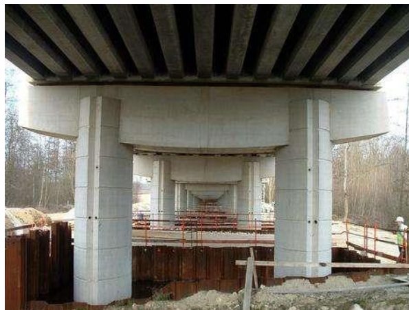
Figure I-4 : Pont à poutres PRAD [18].
