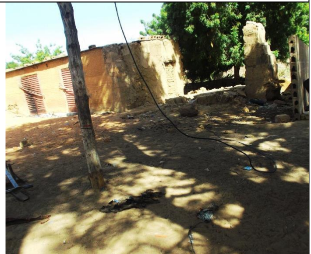
Photo 6 : Câble électrique gisant par terre à Markoye
