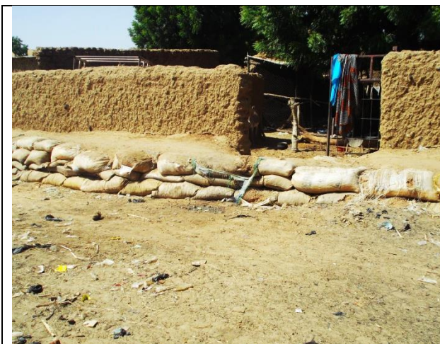
Photo 7 : Batardeau de protection en sacs de sable
