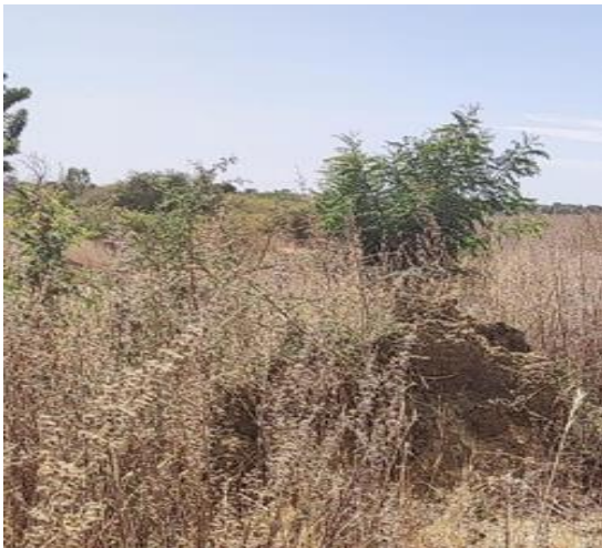
Image 1: Développement de termitières sur la digue
