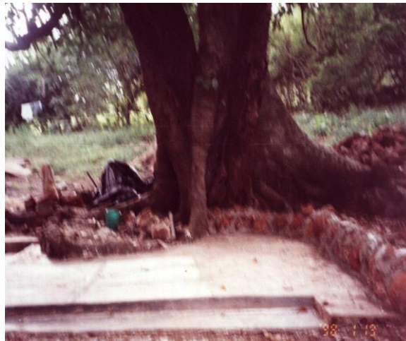
Photo 5 : Protection de la source
