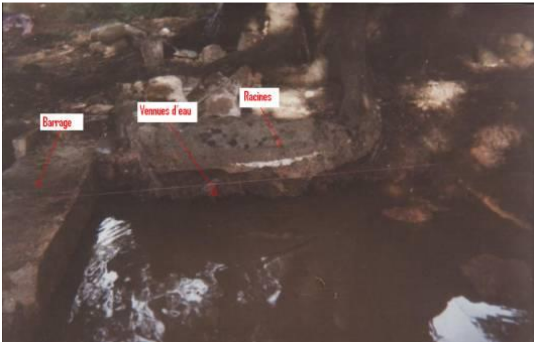
Photo.4 : fouille de la source
